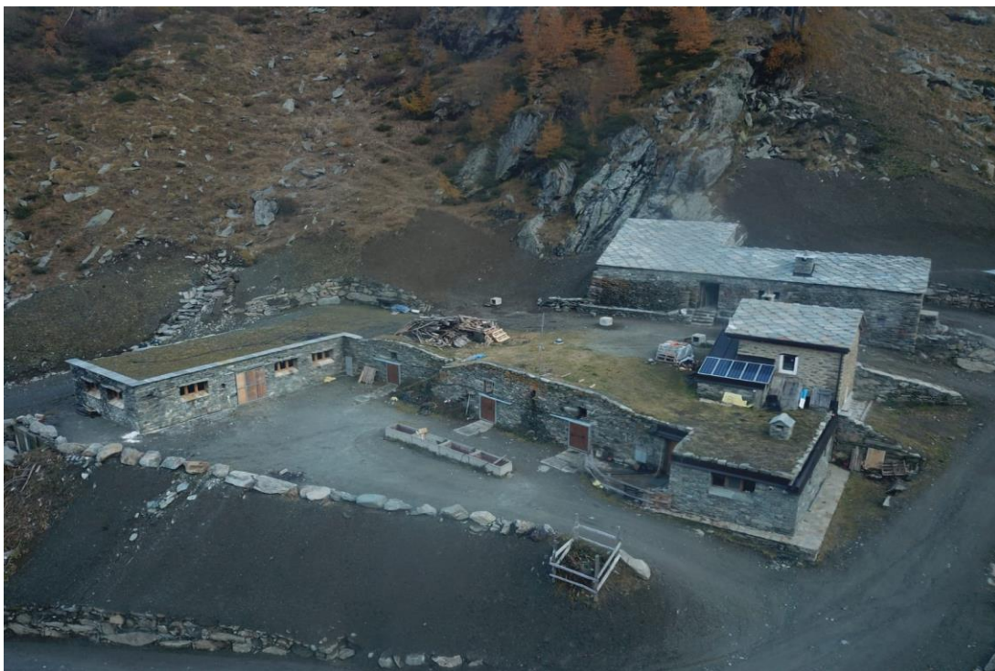
Ristrutturazione di un fabbricato d'alpe idoneo alla produzione della fontina DOP VdA
