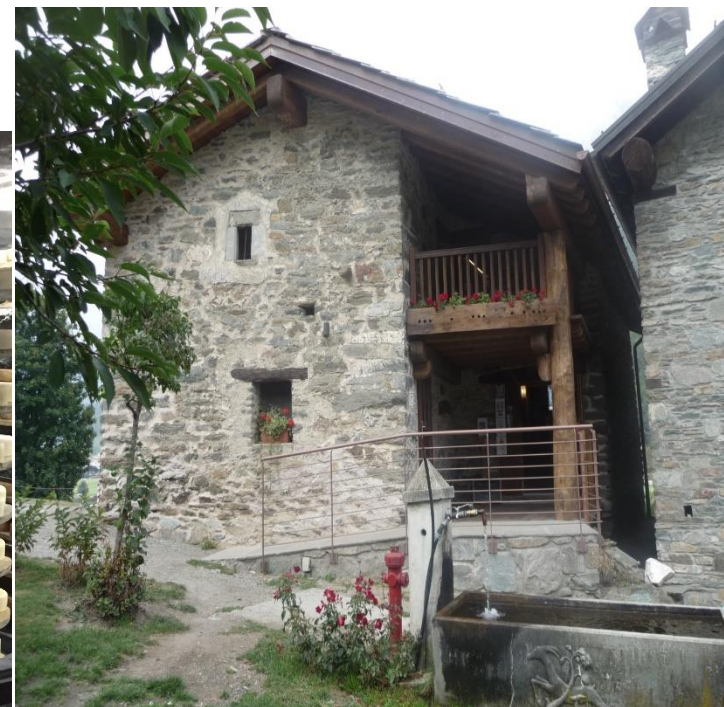
Realizzazione di un ristorante mediante recupero di un fabbricato storico, comune di Brusson
