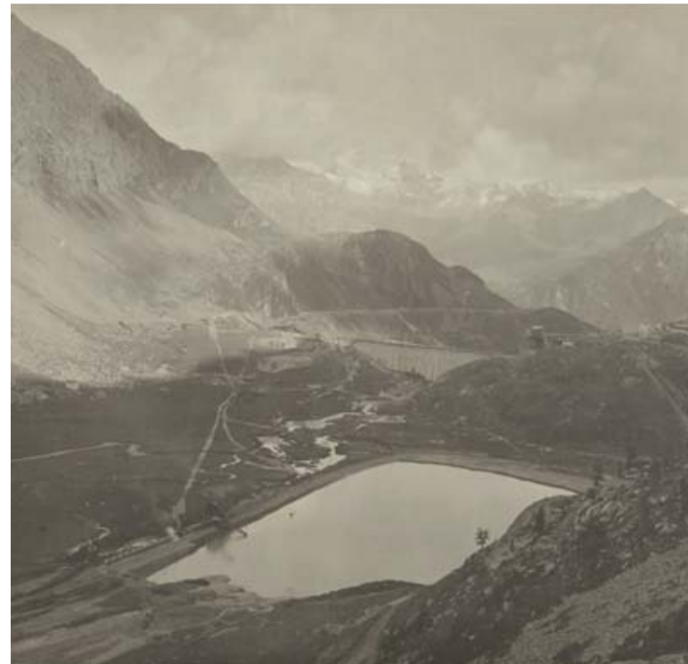
Costruzione della diga di Cignana - 1927
