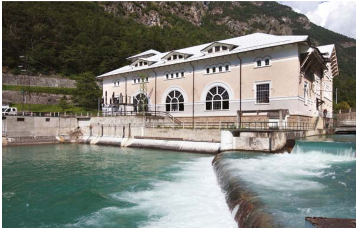
Centrale di Covalou
